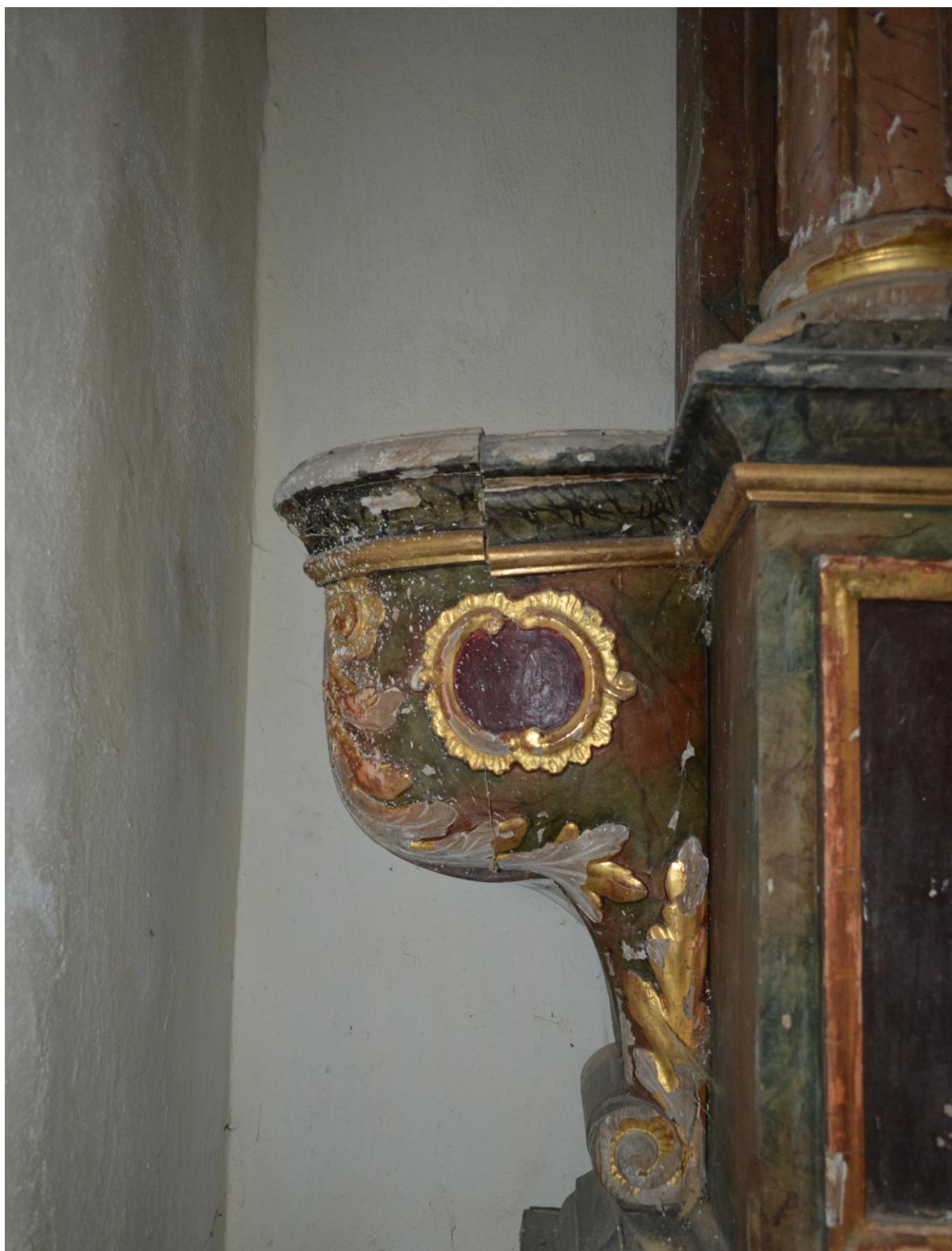
Obrázek 7: Detail rozvolněné konzoly vlevo
