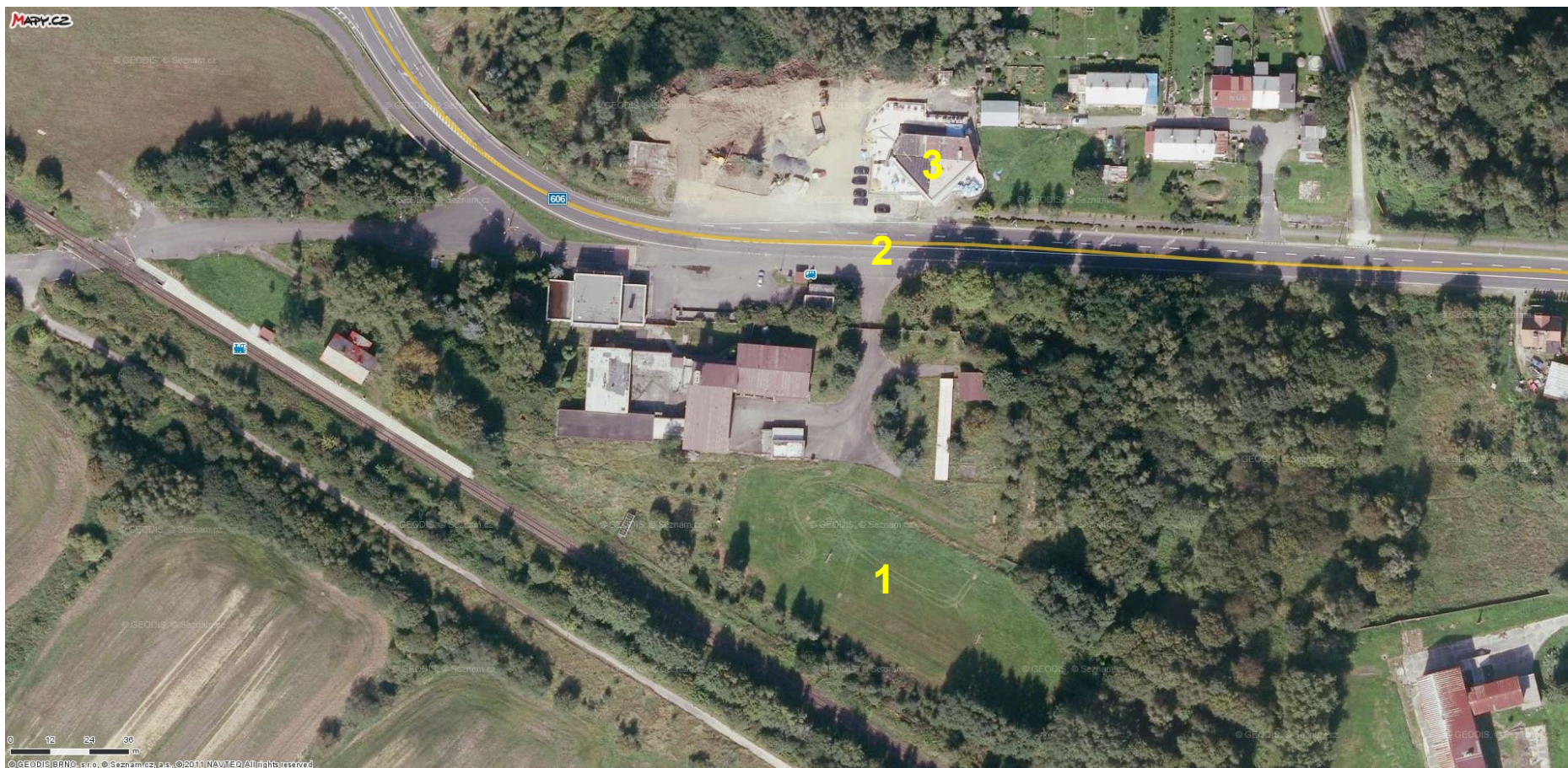
Obr. č. 1. Ortofoto snímek (Zdroj: www.mapy.cz ) s vyznačením členění stavby: 1 = navrhované parkoviště se 173 parkovacími místy; 2 = silnice II/606; 3 = dnešní kasino „Casino Admiral Pomezí nad Ohří“ (ortofoto je staršího data, z doby výstavby)
